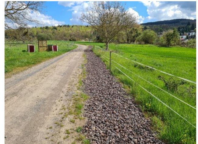
Straßenbegleitende Rigolen in Oberbieber, Quelle: BCE
